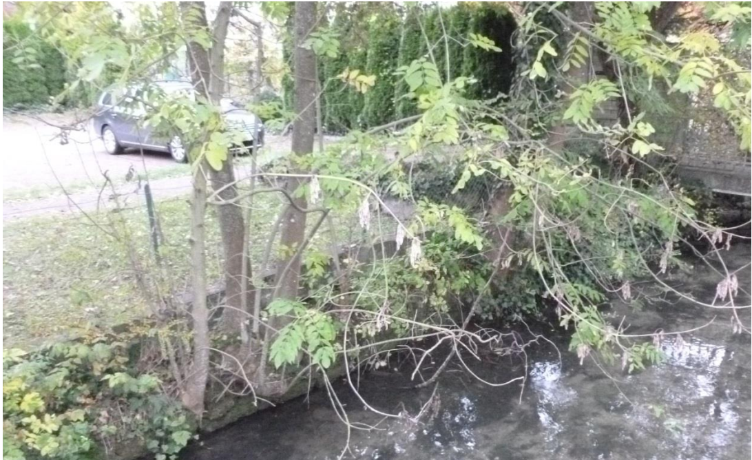
Fritz Planung GmbH – Seitlicher Blick von Station 5 km + 469 m
