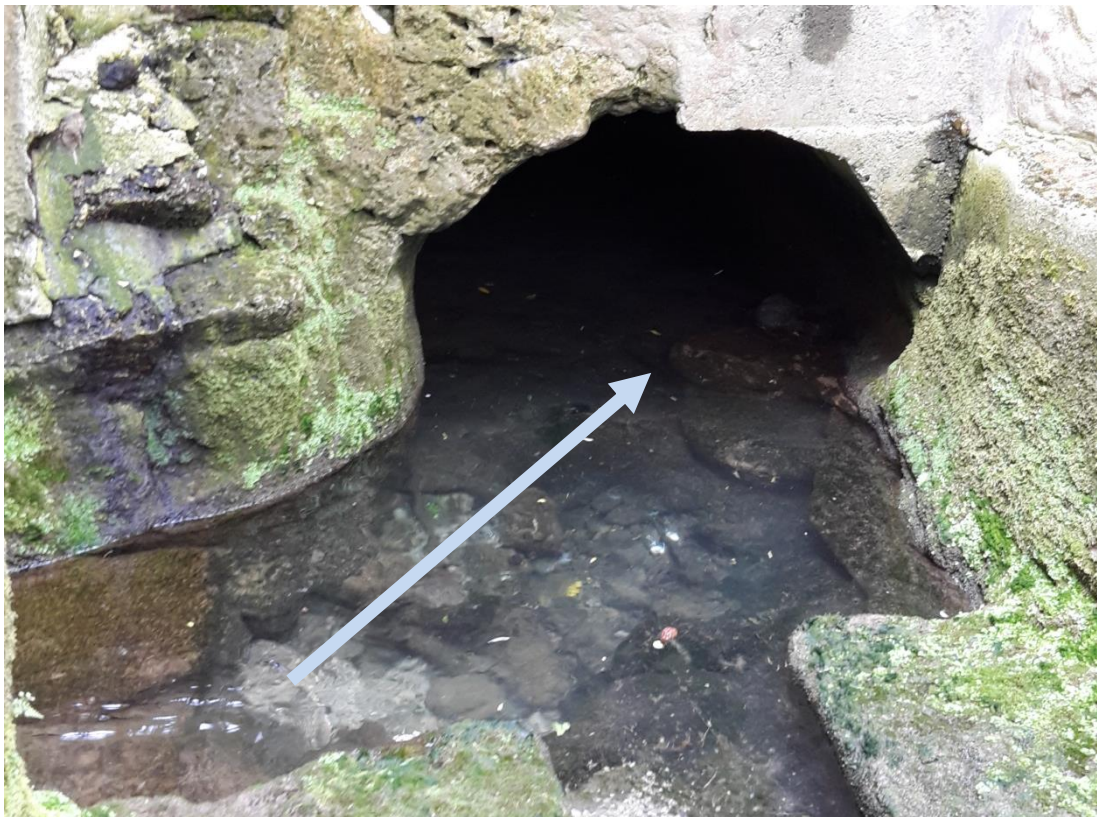
Fritz Planung GmbH – T12, Verdolung für Wasser vom Streichwehr
