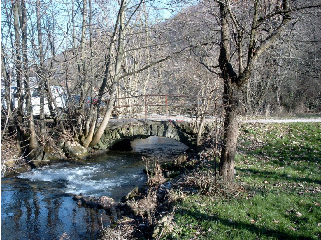
ISTW – Hochwassergefahrenkarten Vermessung 2004, Blick in Fließrichtung am Profil 10090-05920-01 (Station 3 km + 886 m)
