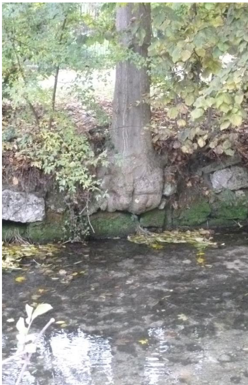
Fritz Planung GmbH – seitlicher Blick Station 2 km + 721 m
