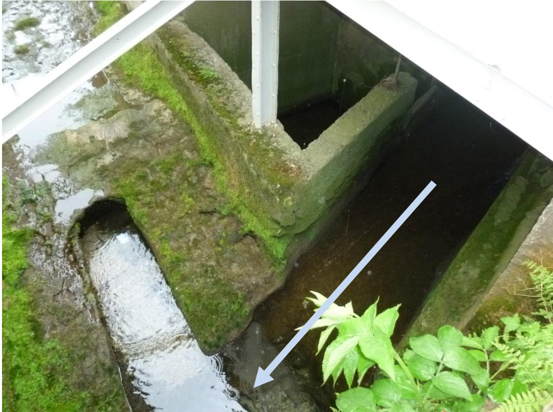
Fritz Planung GmbH – T12, Blick auf Hochwasserentlastungsbauwerk, Streichwehr Zulauf rechts
