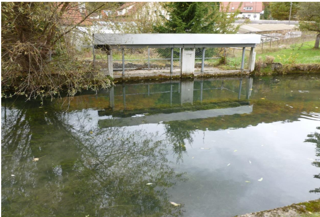
Fritz Planung GmbH – Blick auf den Umlauf bei Station 2 km + 439 m
