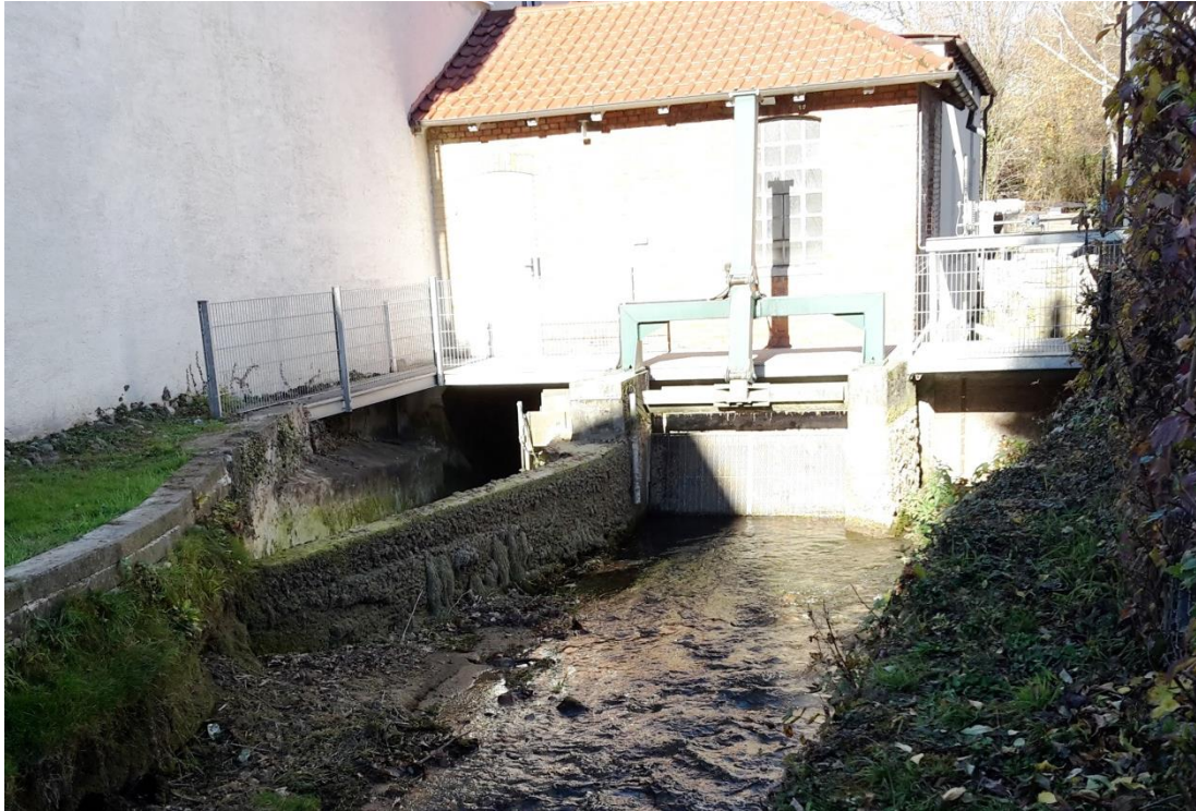
Fritz Planung GmbH – T12, Blick auf Streichwehr (Links), Einlauf (Mitte) und Entlastung (Rechts)
