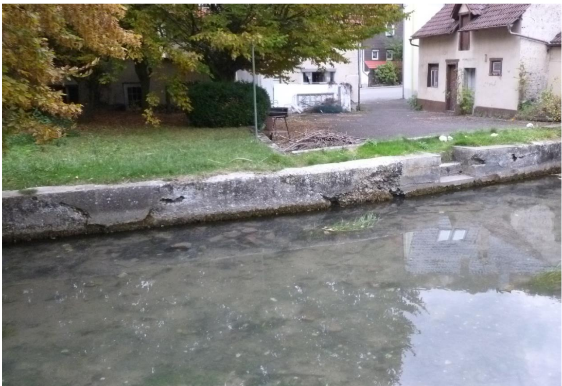
Fritz Planung GmbH – Seitlicher Blick von Station 5 km + 442 m
