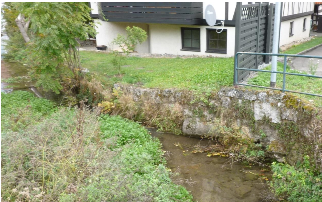
Fritz Planung GmbH – seitlicher Blick bei Station 2 km + 298 m
