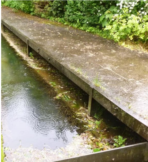
Fritz Planung GmbH – T8, Streichwehr (Links), Hochwasserentlastung (Rechts)
