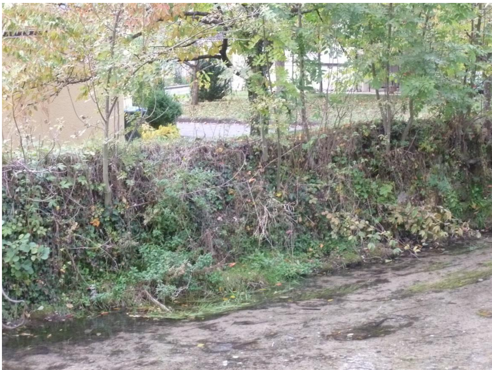
Fritz Planung GmbH – seitlicher Blick auf Ufermauer bei Station 1 km + 312 m
