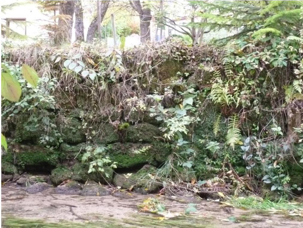
Fritz Planung GmbH – seitlicher Blick auf Ufermauer bei Station 1 km + 279 m
