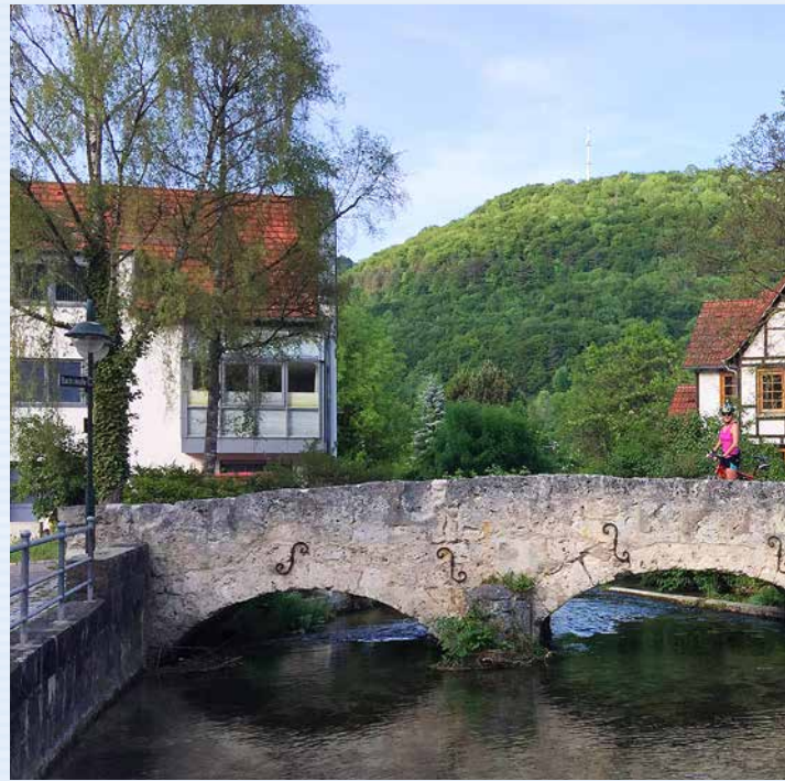
Echazbrücke an der Ludwigstraße
